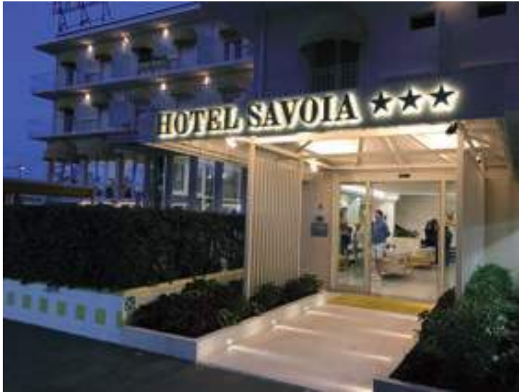
Il nuovo ingresso su via della Repubblica, ultimo lavoro targato 2024.
